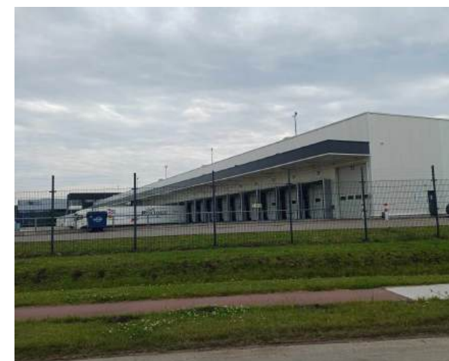
Laad/loskades t.h.v. Van Rooijen Logistiek
