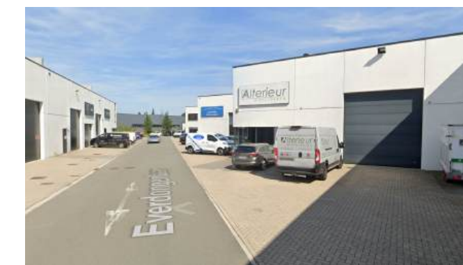
KMO-units op het bedrijventerrein
