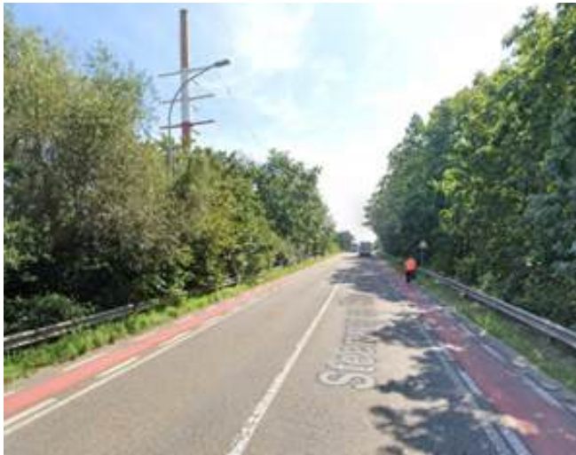
(3) Fietsinfrastructuur Brug Stwg op Tielen
