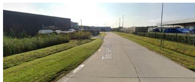
Gescheiden riolering en open grachten t.h.v. Treskensdijk
