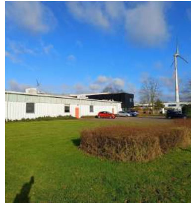
Inefficiënt ruimtegebruik (afstand/buffer t.o.v. perceelsgrens, éénlaags gebouw, ..)
